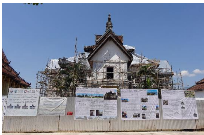
Fig.2 - La bibliothèque de Vat Muang Kang en cours de restauration, en 2025
